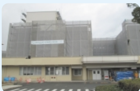
現在2~3階部分を工事中
