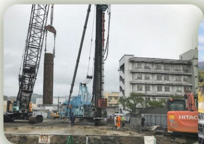
杭打ちの様子
